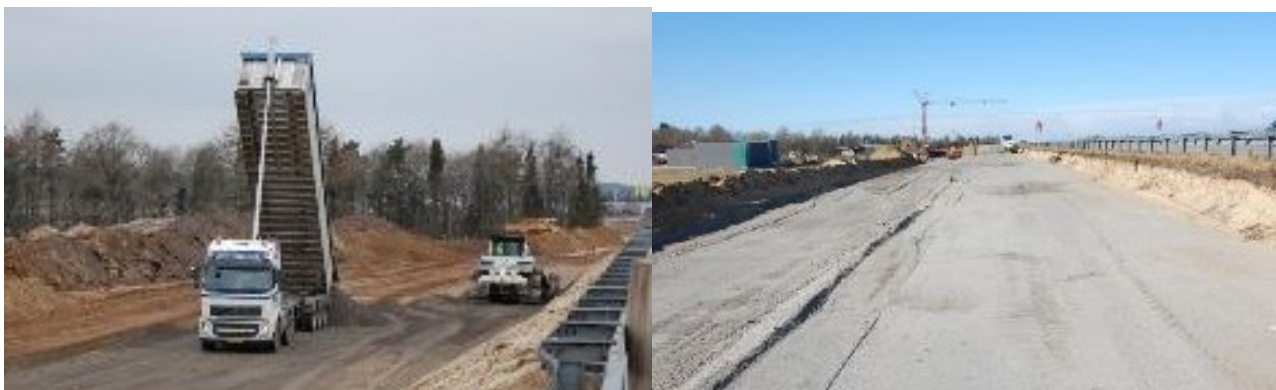
Eksempel på slaggegrus anvendt i bundsikringen af veje.
