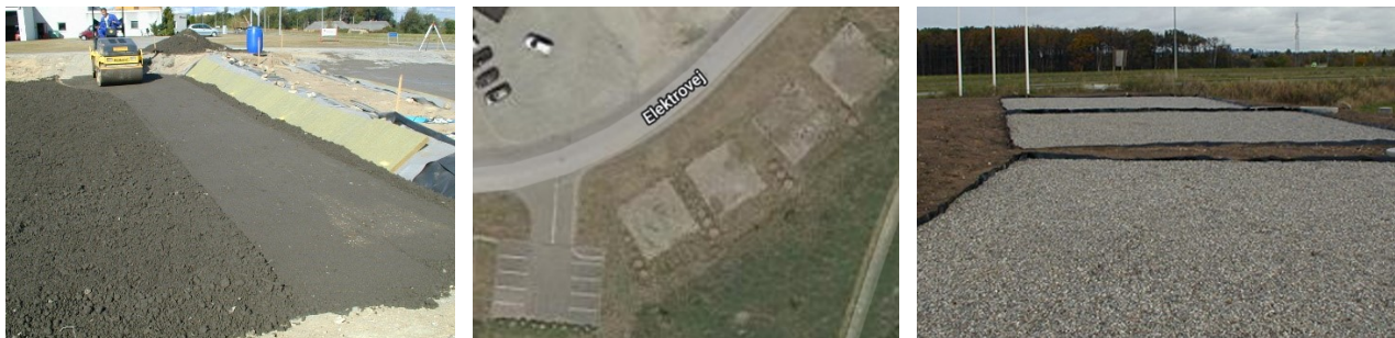
Fotos fra demonstrationsanlægget for slaggeanvendelse på Ydernæs i 2002 - 2019 (DanWS).
