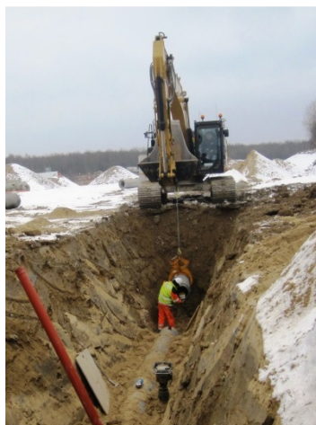
Figur 2: Udførelse af en ledningsgrav i en vejdamning som er kalkstabiliseret helt fra bunden. Siderne står faste, stejle og glatte. Føreren af gravemaskinen fortalte at han godt kunne mærke at der skulle "tages hårdere fat", men at den kalkstabiliserede jord ellers var udmærket at grave i. Efter tilbagefyldning og komprimering i ledningsgraven, genvinder jorden sin styrke fra før opgravningen.
